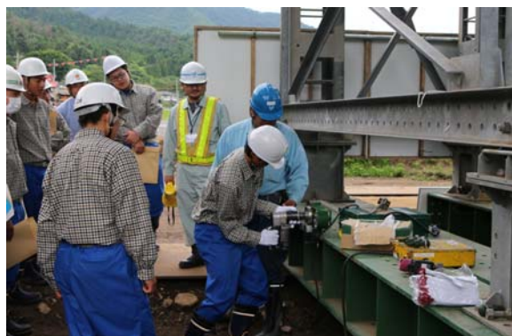
▲機械を使用してのボルト締め体験
