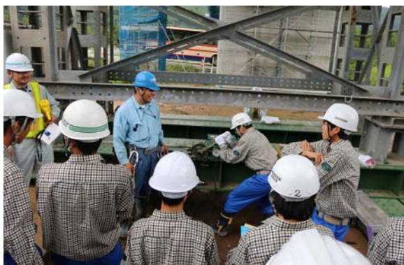
▲横川高架橋にて、ボルト締め体験(工具で手締め)
