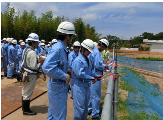
▲荒屋舗橋において、安全帯の着用体験
