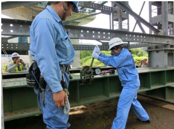
▲横川高架橋にて、ボルト締め体験(工具で手締め)
