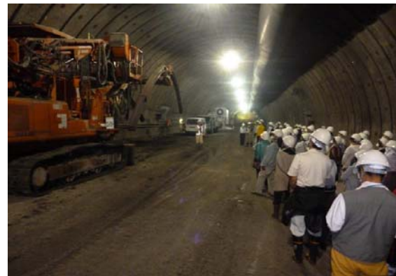
▲トンネル施工機械の説明状況
