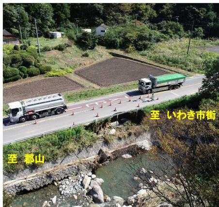
写真① 大雨により路肩法面が崩壊
