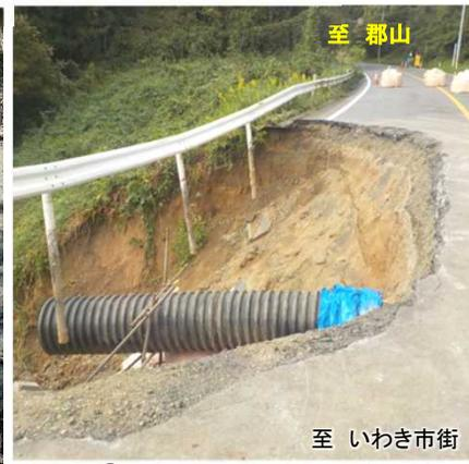
写真④ 大雨により法面が崩壊
