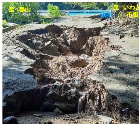
写真③大雨により法面が崩壊
