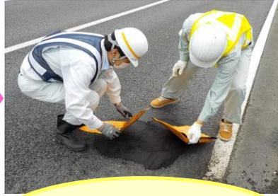
常温合材というアスファルトで応急復旧します。
