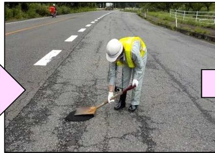
常温合材（＝アスファルト）で穴埋めします
