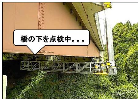
平維持管内にある橋梁を順番で点検しています。表面はもちろん、橋の下からも点検し、腐食やヒビ・漏水などが確認出来た場合、その度合いのランクで修繕していきます。
