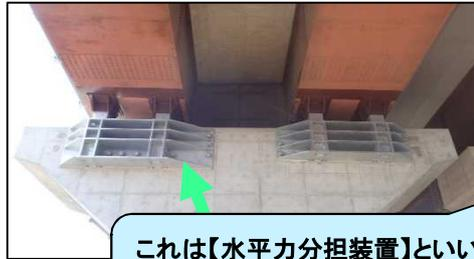
これは【水平力分担装置】といいます。地震時に橋が動くことによって、水平力に抵抗することができ、橋梁の耐震性能が向上します。
