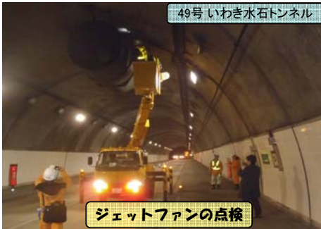
49号 いわき水石トンネル
