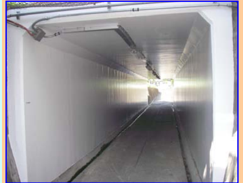
【明るく、安全な地下道に改善】
