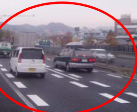
減速マークを設置
