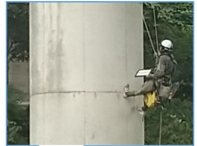
人間がロープで吊られた状態で点検！
