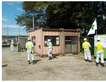
▲点検状況(現場詰所)
