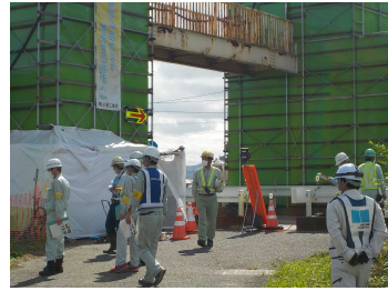
▲歩道橋点検状況
