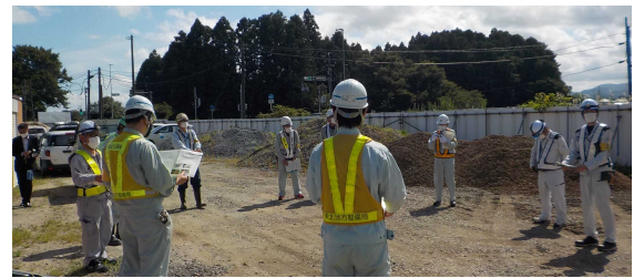
▲工事概要の説明
