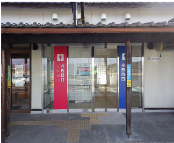
トイレ入口(自動ドア)
