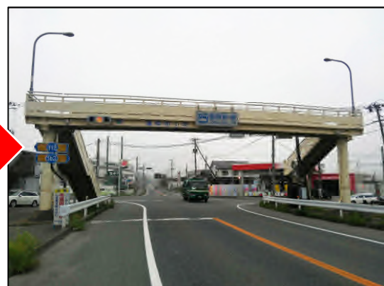
▲補修完成(南側より)
