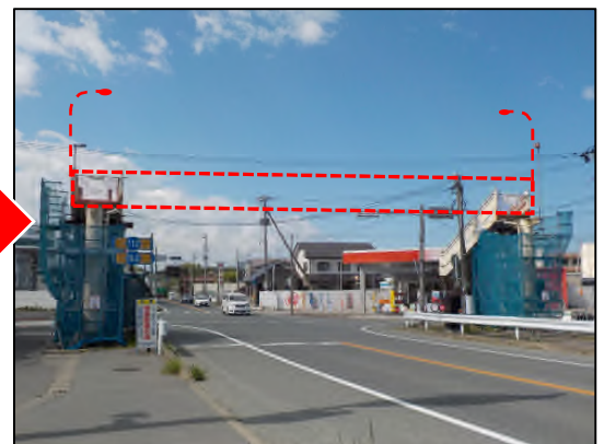
補修のために一時撤去(R2年4月) (工場で補修中)
