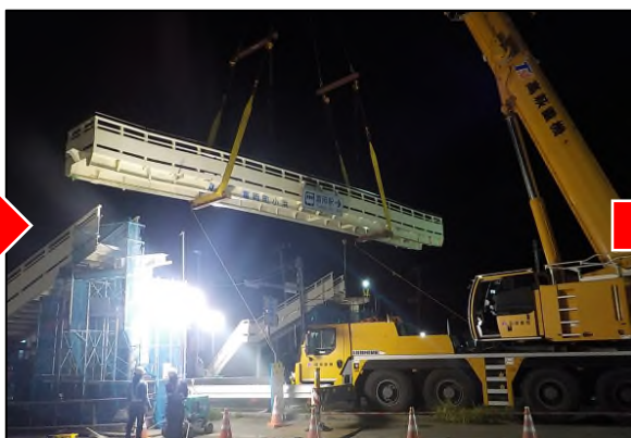
補修した歩道橋の再架設(R2年7月8日)
