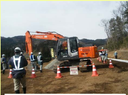
間ノ次郎地区改良工事の現場をパトロール
