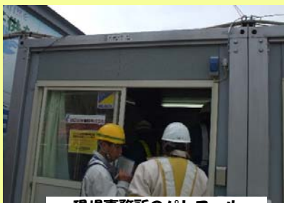
現場事務所のパトロール
