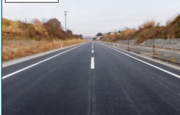
路面亀裂のため舗装工事を実施しました。
