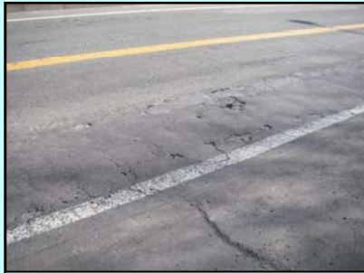
▲車道舗装面の亀裂は、今後、損傷の拡大が懸念されます。
