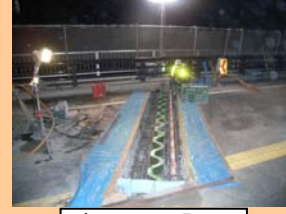
ジョイント設置
