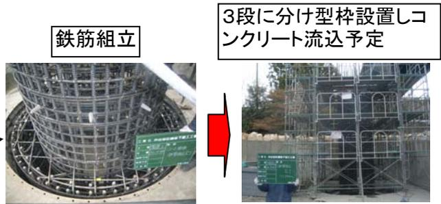
3段に分け型枠設置しコンクリート流込予定
