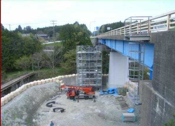
榑葉町井出地内の井出川橋に歩道を設置するため側道橋を現在工事中です。歩道は橋の上流側に設置する計画であり、先日歩道の橋脚を支える深さ9mの深礎杭を打ち終わりました。現在橋脚本体の鉄筋が既に組み終わり、一段目の型枠を設置しコンクリートを流し込んでいます。「略図」のように今後随時施工予定であり、併せて近隣の歩道も整備中です。近隣の住民の方には何かとご迷惑等お掛けいたしますがご理解のほどよろしくお願いいたします。
