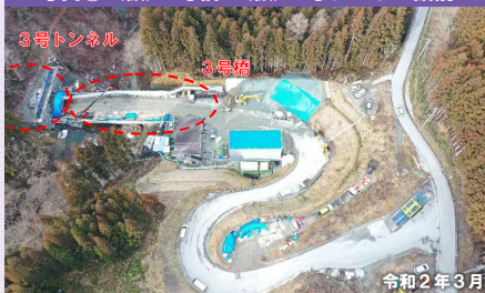
写真② (仮)3号橋・(仮)3号トンネル掘削
