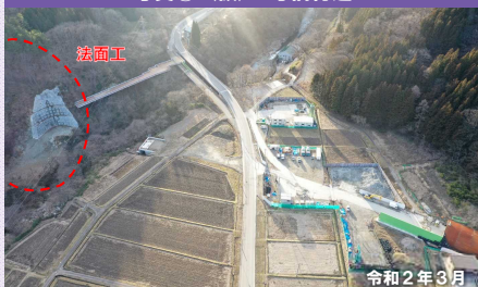
写真① (仮)2号橋付近
