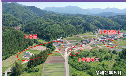
写真③ (仮)5号橋付近
