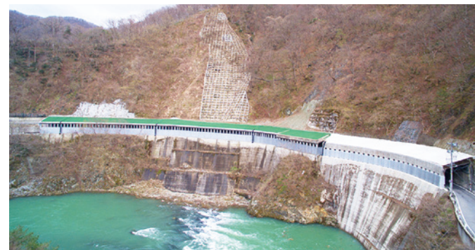
沼尾シェッド 所在地: 福島県下郷町 橋長: 189m 路線: 町道 沼尾線 直轄診断: 平成27年 建設年: 昭和33年 事業完了: 平成29年度
