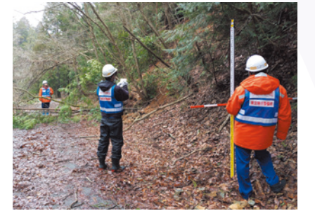
土砂崩れの被災状況調査
