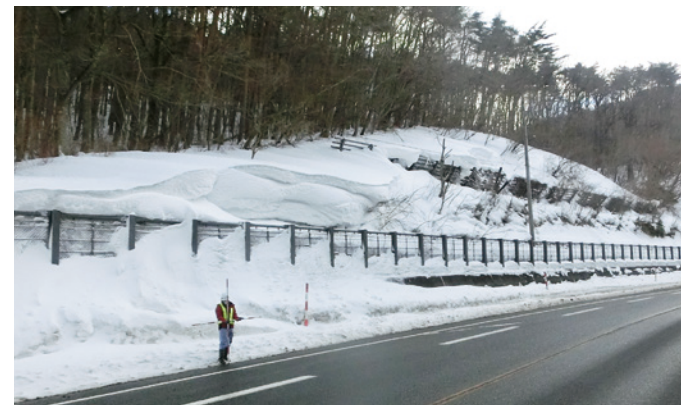
雪庇発生状況の点検
