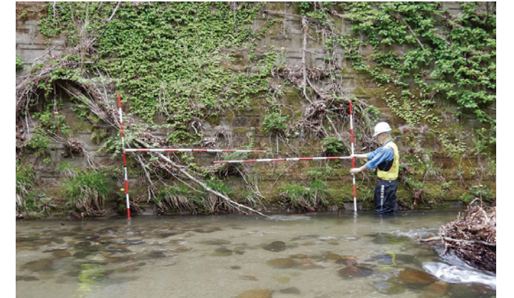
擁壁(護岸)の点検
