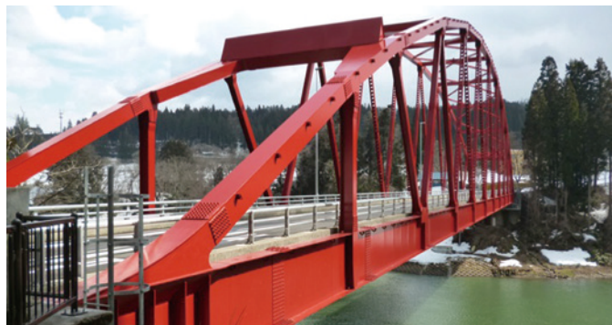
三島大橋 所在地: 福島県三島町 橋長: 131m 路線: 町道 宮下・名入線 直轄診断: 平成26年 建設年: 昭和50年 事業完了: 平成28年度
