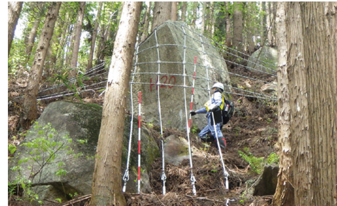
対策(ロープ掛け)後の点検
