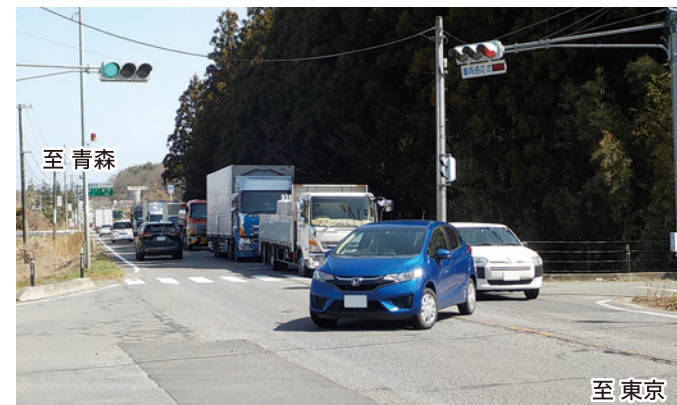
右折レーン未整備箇所(熊野森交差点)
