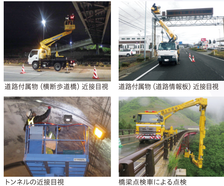
トンネルの近接目視 橋梁点検車による点検
