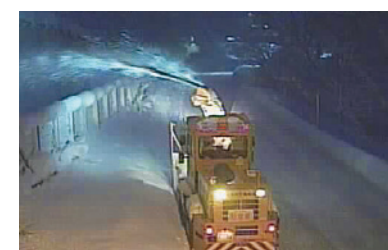
集中除雪作業の状況
