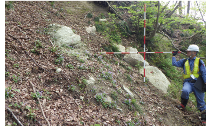
法面(転石・浮き石)の点検
