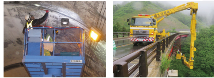
トンネルの近接目視 橋梁点検車による点検
