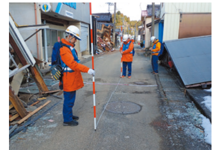
町道の被災状況調査
