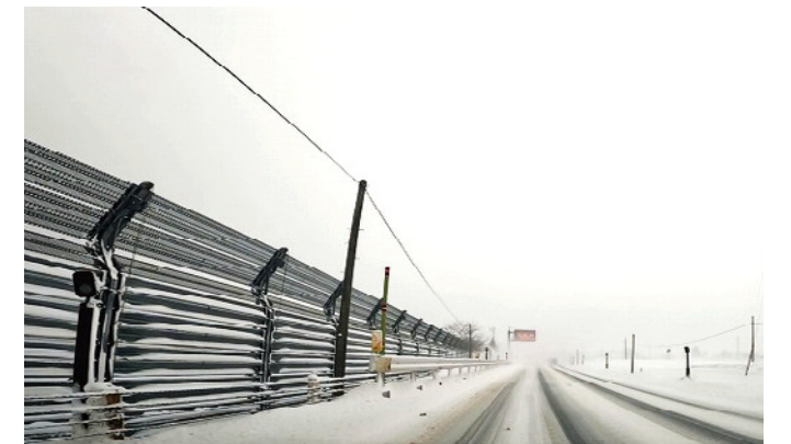
対策(防雪柵設置)後の点検
