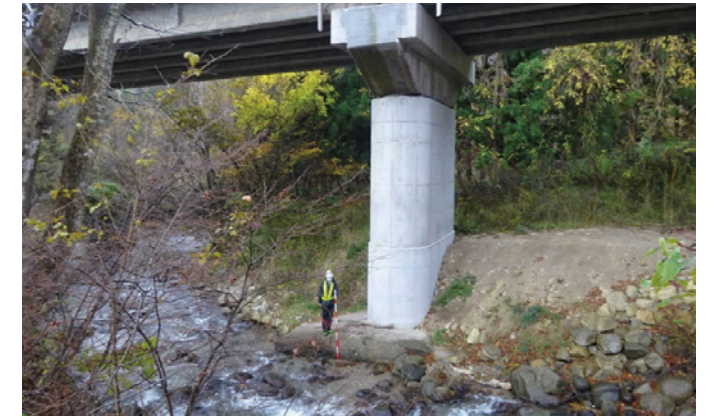
橋脚基礎洗掘の点検
