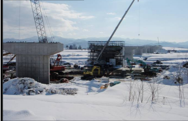
米沢大橋(福島方向)
