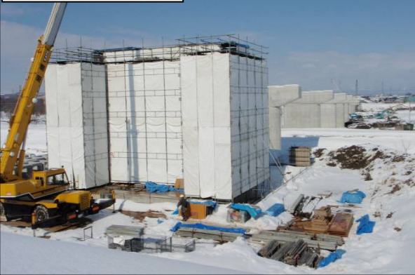
米沢大橋(山形方向)
