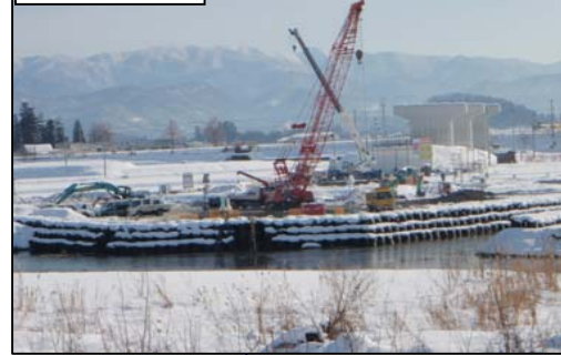
米沢大橋下部工
