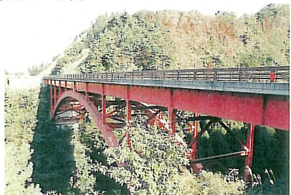
▲平成19年度着手する菅波大橋の全景
