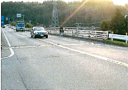
▲歩道未整備状況
