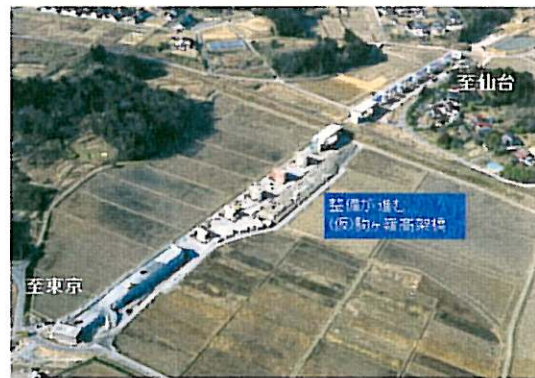
▲（仮）駒ヶ嶺高架橋の工事状況
