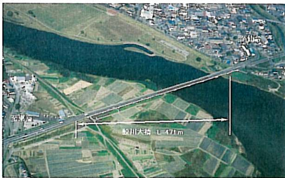
▲鮫川大橋状況写真
