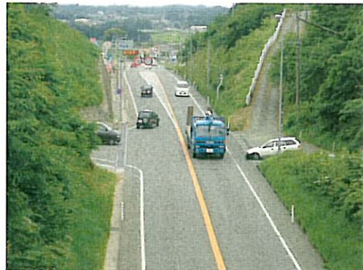
▲町道取付状況
