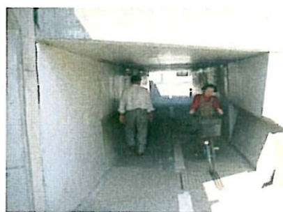
▲鹿島地下道の現況
