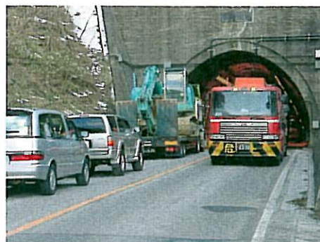
▲大型車のすれ違いが困難な現在のトンネル
