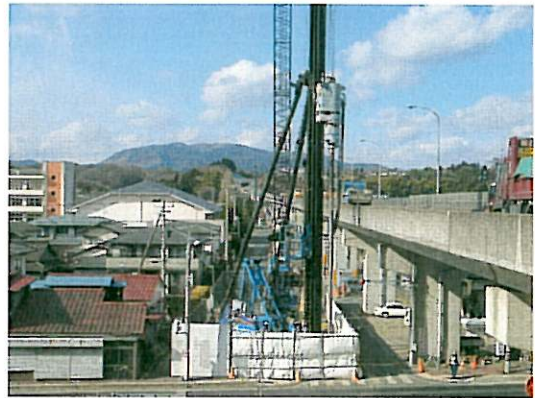
▲内郷高架橋工事状況
