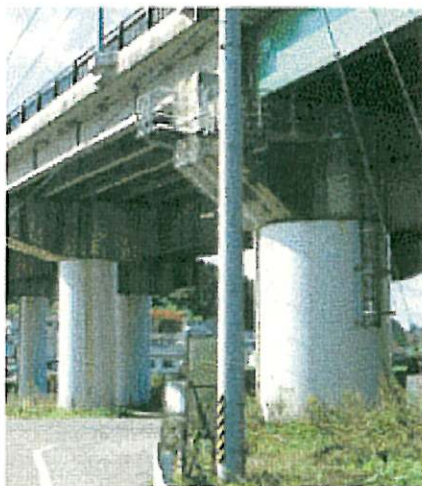
▲ 橋脚巻立ての施工例
