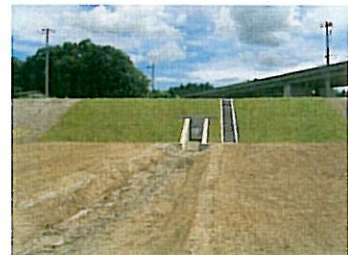
緊急復旧後(全面改築)
