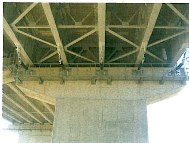
▲ 落橋防止装置の施工例
