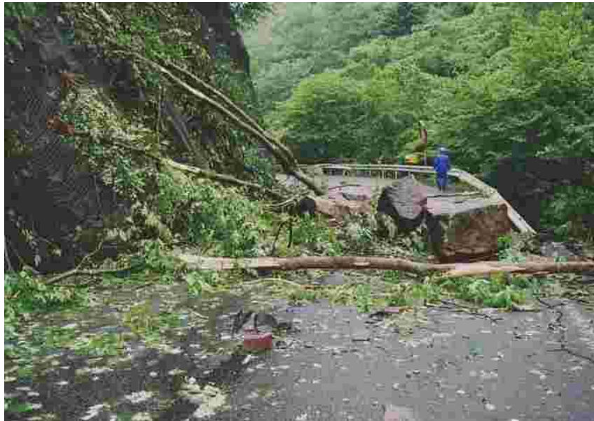
▲ H18.6.7の落石・道路崩壊 (写真・左, 新聞記事・右)
