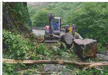
▼落石災害発生(H18)約1ヶ月全止
