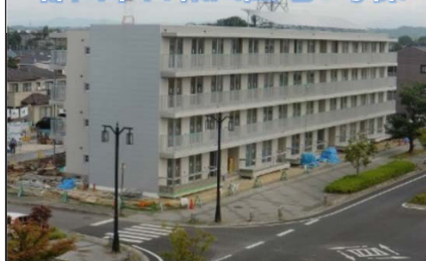
郡山市目和田団地1号棟
