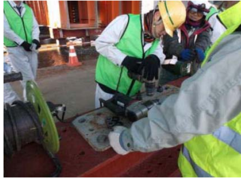
▲高力ボルトの締め付け体験(26.12.3)
