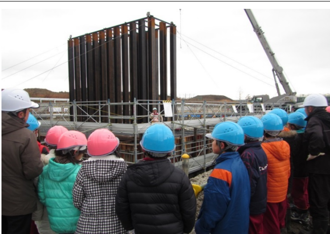
見て(施工状況の見学)
