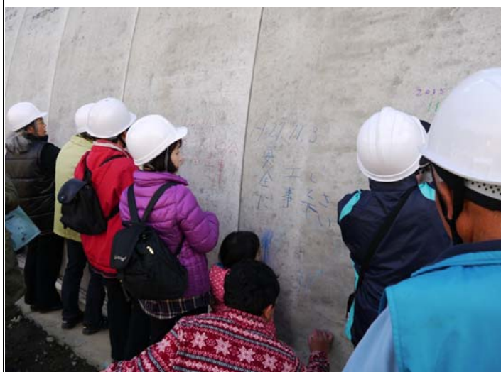
アーチカルバート外壁への寄せ書き状況
