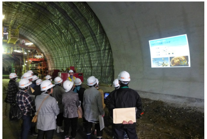
【コンクリートをスクリーンにしてトンネルの施工方法を学ぶ】
