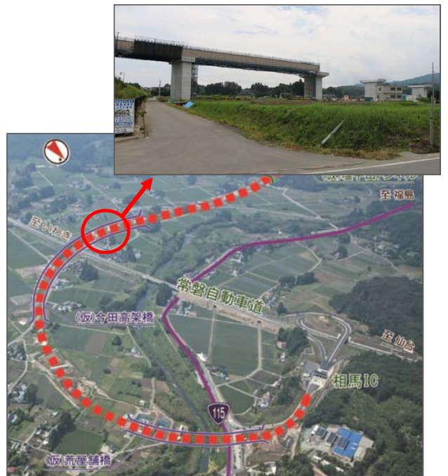
▼今田高架橋現地視察場所
