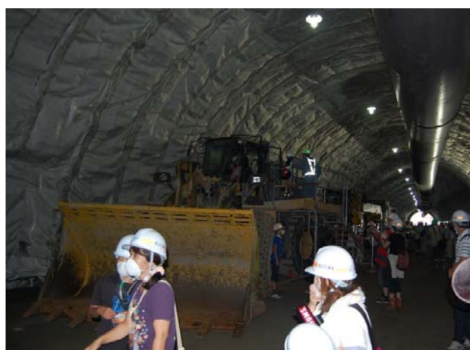
トンネル工事で使用している大型機械への試乗体験
