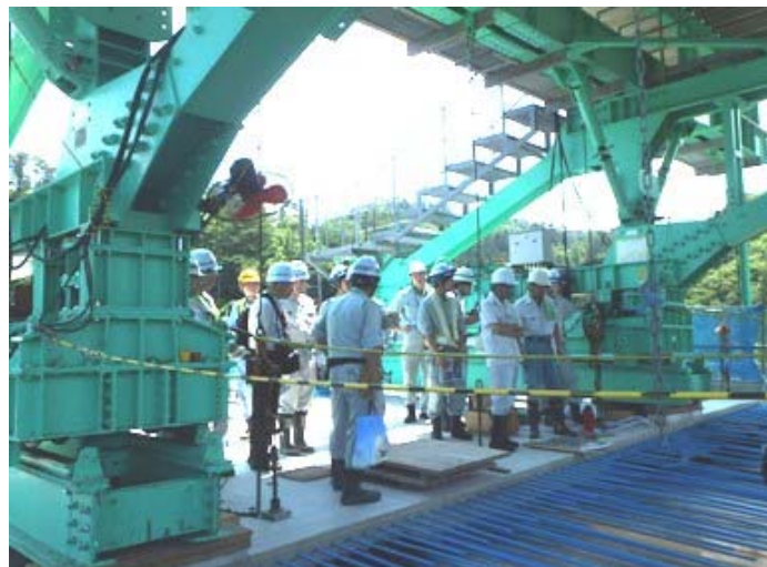
施工状況見学
