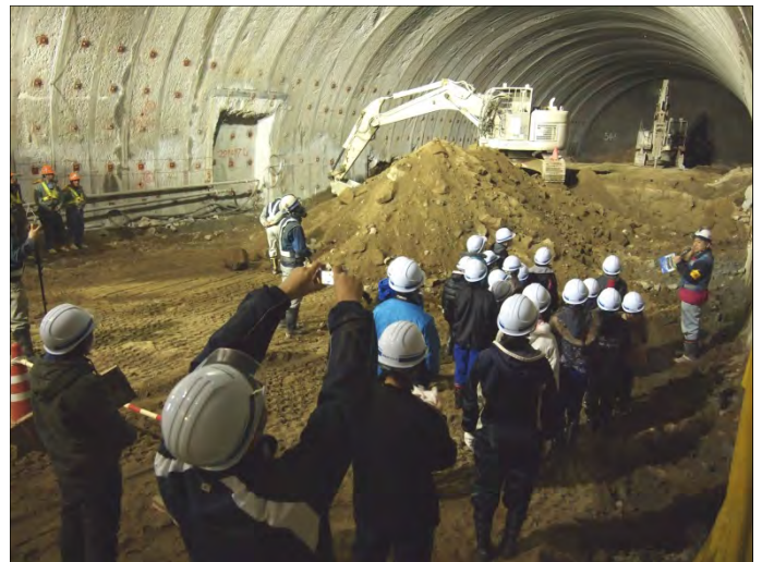
▲トンネル掘削最前線の見学状況
