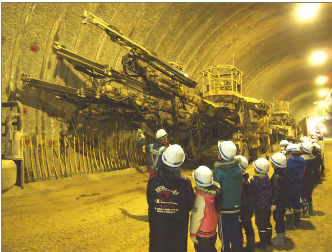
▲トンネル施工機械の見学状況
