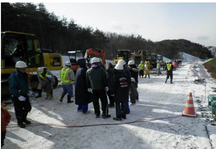
▲ 現場見学状況
