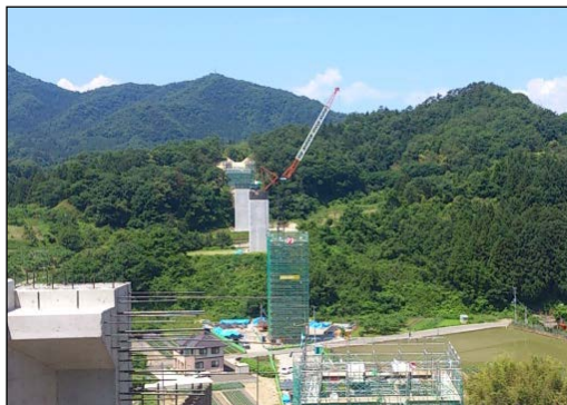
▲ 境ノ目トンネルから臨む月館高架橋
