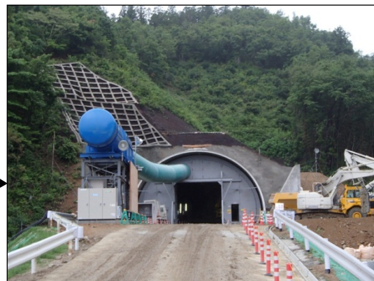
▲ 坑口部の現在の状況
