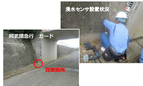
◀▲浸水常襲箇所に浸水センサ設置
