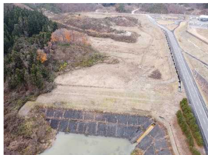
掘削土搬入前（令和3年11月）
