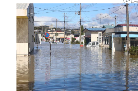
R1.10台風19号 浸水状況
