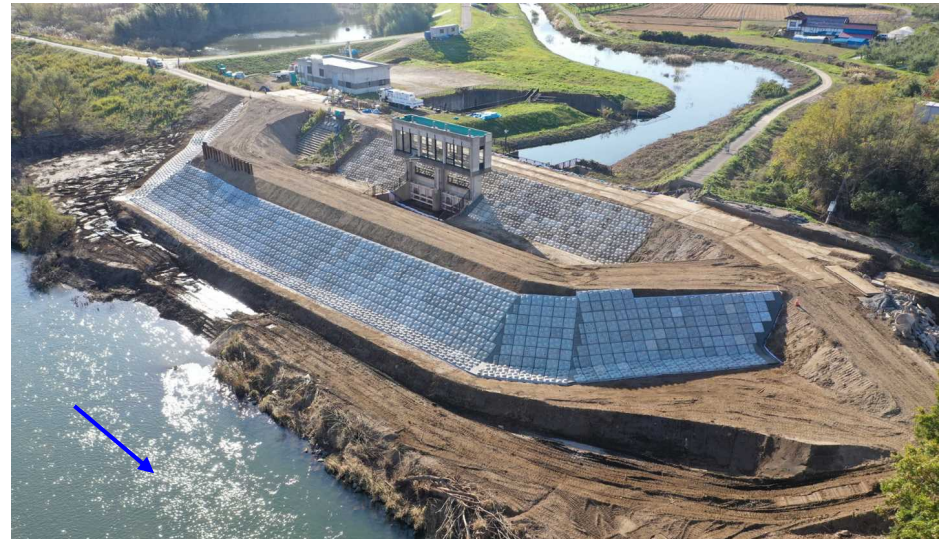
須賀川市浜尾地区 緊急復旧工事完了状況(11月9日撮影)
