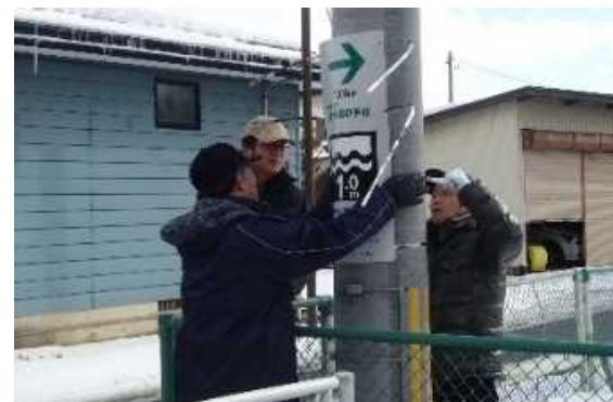
電柱などに浸水の深さ、避難ルートの案内看板を設置
