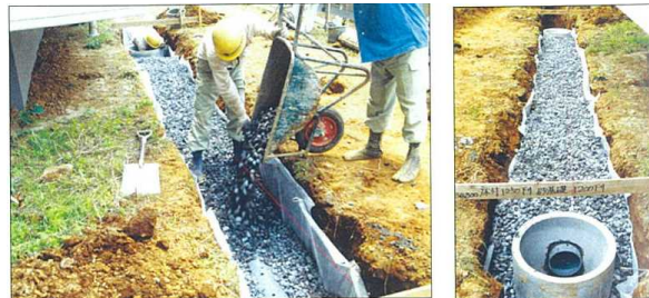
浸透トレンチ
