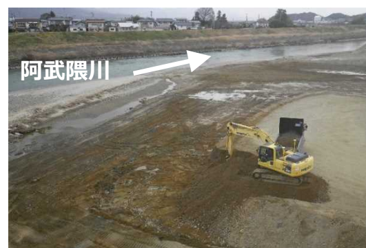
バックホウによる掘削
