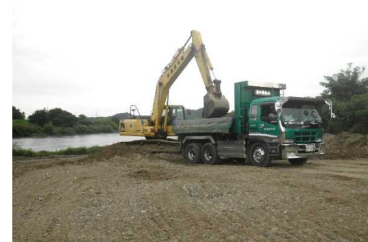
ダンプへの積み込み
