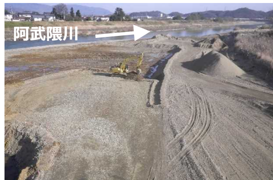
バックホウによる掘削
