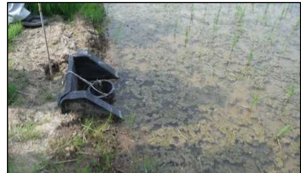
田んぼダム落水柵設置状況
