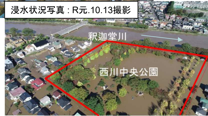
浸水状況写真: R元.10.13撮影
