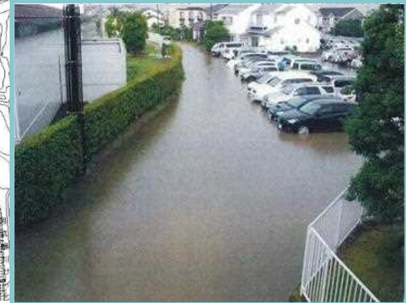
浸水被害状況 平成28年8月2日
