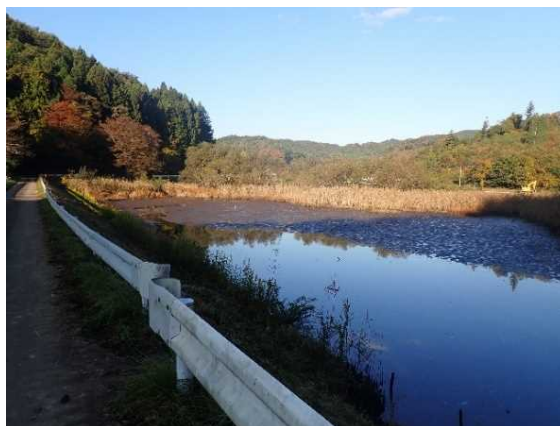
ため池浚渫前
