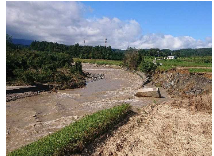
令和元年 東日本台風(阿武隈川)
