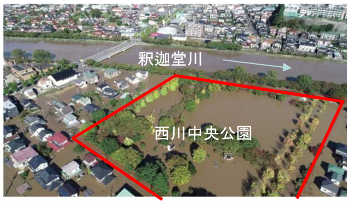
浸水状況(令和元年10月撮影)
