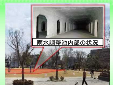
下水道事業による雨水貯留施設の例(郡山市)
