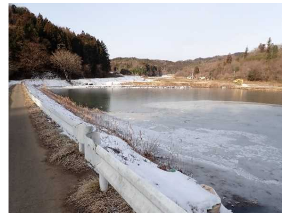
ため池浚渫後
