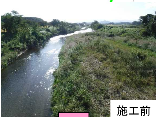
代表施工箇所写真【釈迦堂川⑫】
