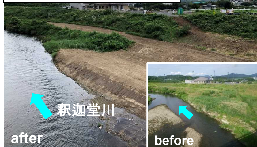
写真①(未来大橋下流側)
