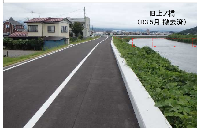
【左岸】旧橋撤去、天端舗装完了(令和3年6月)
