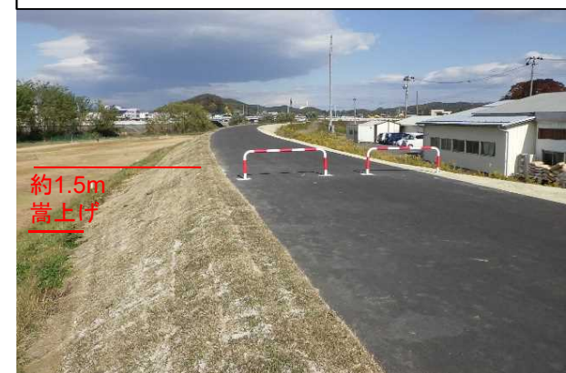
【右岸】堤防嵩上げ完了(令和2年5月)
