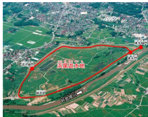
浜尾遊水地（既設）
