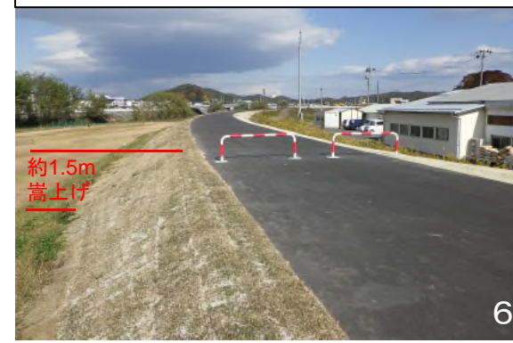
【右岸】堤防嵩上げ完了(令和2年5月)
