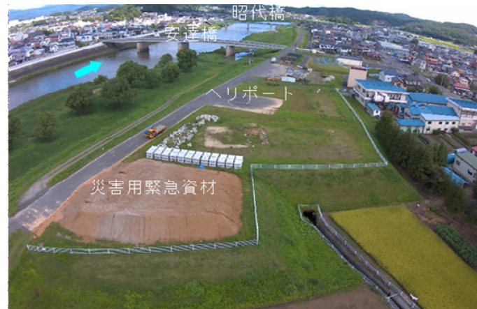
○ 河川掘削残土を利用した多目的高台
