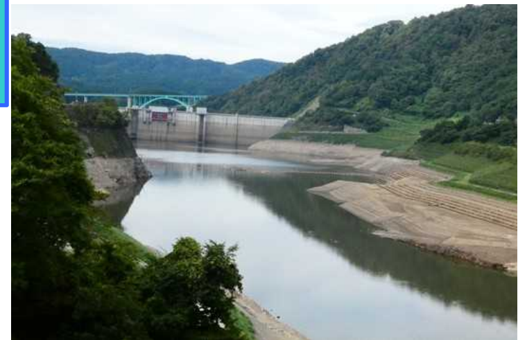
貯水位低下時の月山ダム貯水池〔9月14日撮影〕
