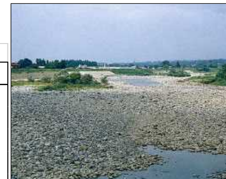
平成6年8月_瀨切れ状況(熊出付近)
