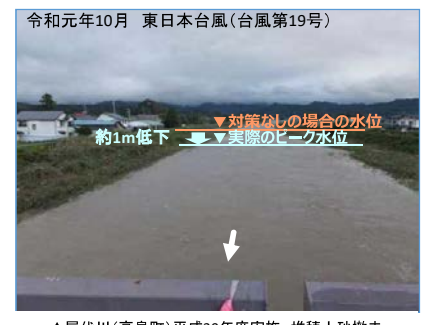
▲ 屋代川(高島町)平成30年度実施 堆積土砂撤去 堆積土砂の撤去により水位が約1m低下と推定 氾濫危険水位を上回ることなく浸水被害軽減に効果を発揮
