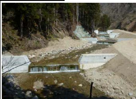
渓床の安定化を図る治山ダム
