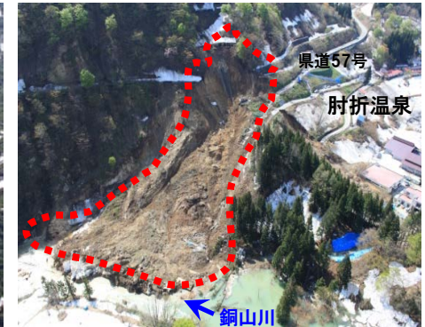
[銅山川流域肘折地区で発生した崩壊(H24.5)]
