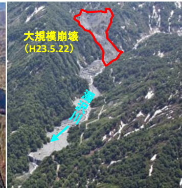
[濁沢川で発生した大規模崩壊(H23.5.22)]
