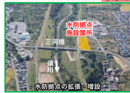
水防拠点の拡張・増設
