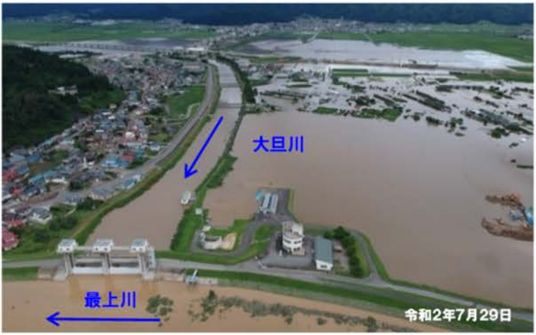
被害状況(浸水被害)
