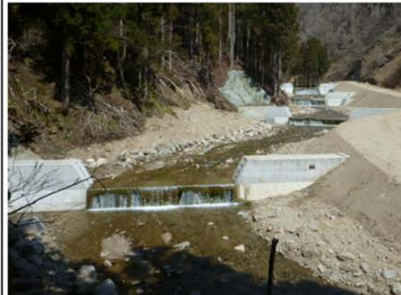
溪床の安定化を図る治山ダム
